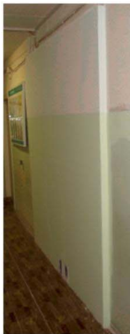
Стена со встроенным теплоаккумулятором ТА-СТЕНА
