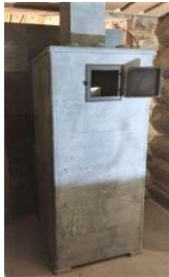
Печи с верхним выходом дымовых газов
