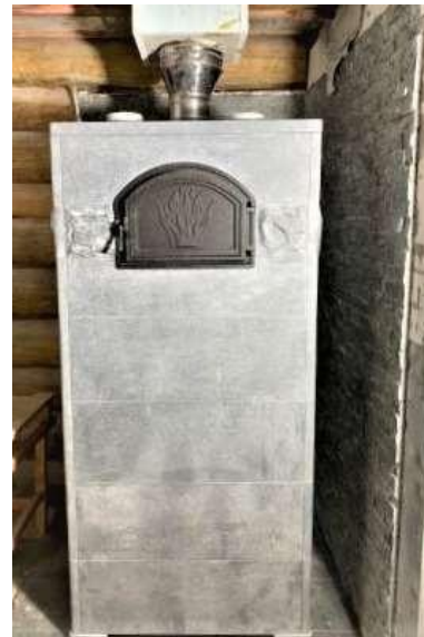
Печи с верхним выходом дымовых газов
