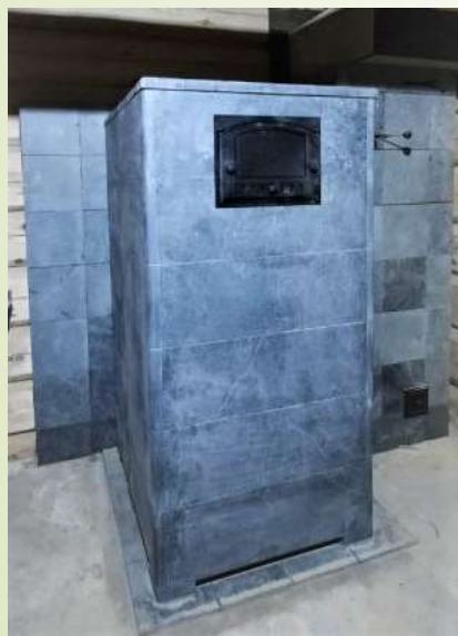
Печь с боковым выходом в теплоизлучатель
