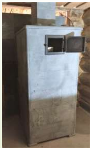
Печи с верхним выходом дымовых газов
