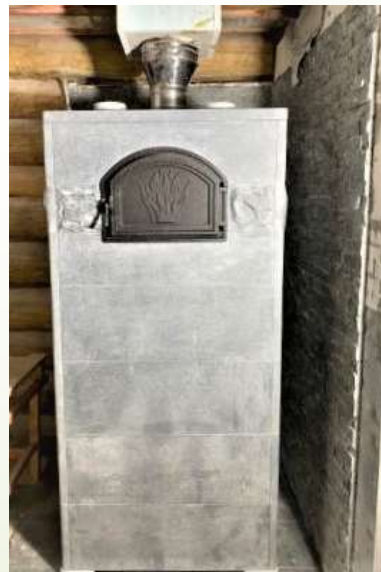
Печи с верхним выходом дымовых газов
