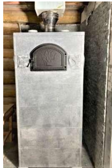
Печи с верхним выходом дымовых газов
