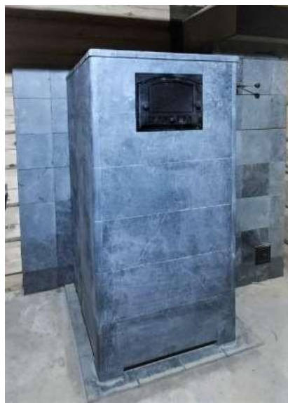
Печь с боковым выходом в теплоизлучатель
