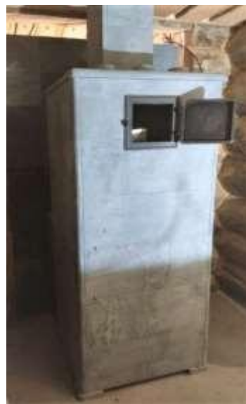
Печи с верхним выходом дымовых газов
