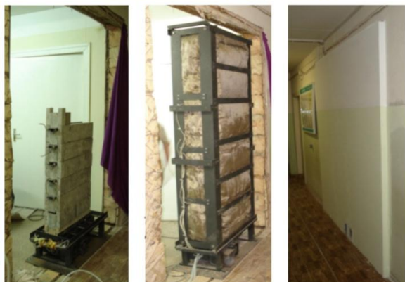
Монтаж теплоаккумулирующего рабочего тела из талькохлорита
