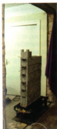
Монтаж теплоаккумулирующего рабочего тела из талькохлорита
