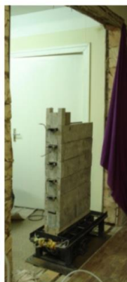
Монтаж теплоаккумулирующего рабочего тела из талькохлорита
